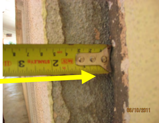
Gambar 4.1 Keretakan Berlaku Di Bahagian Dinding Koridor Laluan Berbumbung
