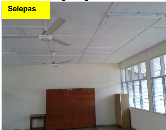
Gambar 4.11 Siling Yang Telah Dibaiki
