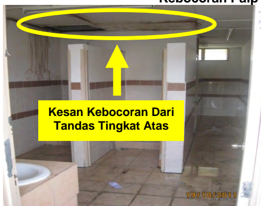
Gambar 4.19 Kebocoran Paip Di Tandas Guru Dan Pelajar
