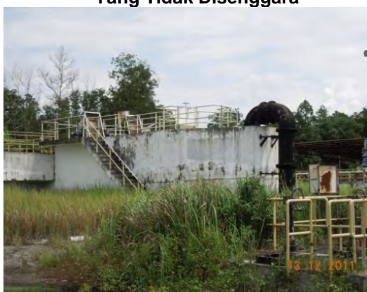
Gambar 10.11 Loji Rawatan Kumbahan Yang Tidak Disenggara
