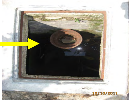
Gambar 4.8 Manhole Yang Tidak Ditutup
