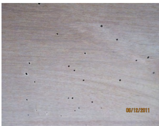
Gambar 5.3 Lubang Kecil Pada Lantai Papan Lapis Yang Ditebuk Kumbang Kayu
