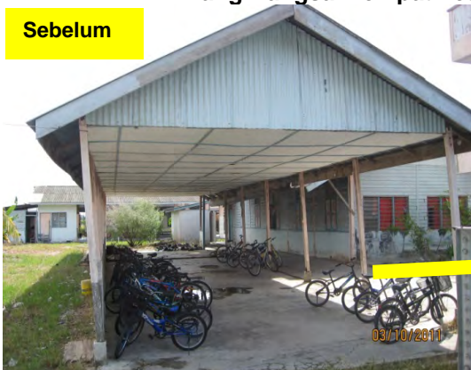
Gambar 4.3 Tiang Bangsal Tempat Letak Basikal Pelajar Yang Telah Reput
