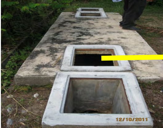
Gambar 4.8 Manhole Yang Tidak Ditutup
