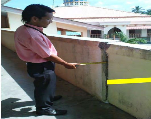
Gambar 4.1 Keretakan Berlaku Di Bahagian Dinding Koridor Laluan Berbumbung
