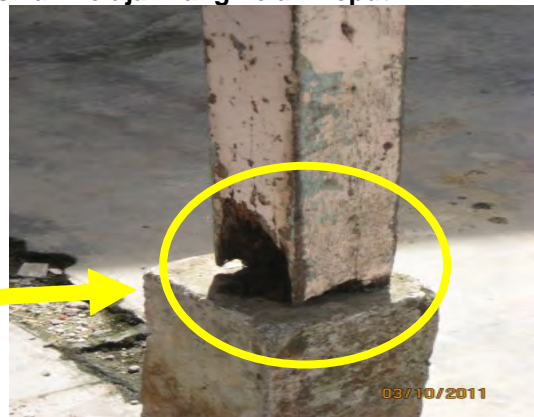
Gambar 4.3 Tiang Bangsal Tempat Letak Basikal Pelajar Yang Telah Reput
