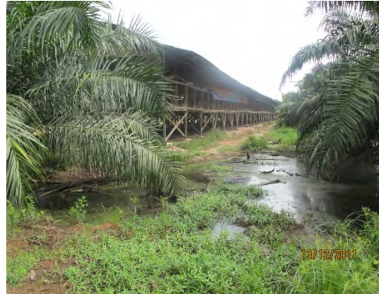
Gambar 5.8 Sistem Perparitan Yang Kurang Sempurna Menyebabkan Air Yang Tercemar Dengan Tinja Ayam Bertakung Dan Menyebabkan Bau Busuk Di Persekitaran Reban
