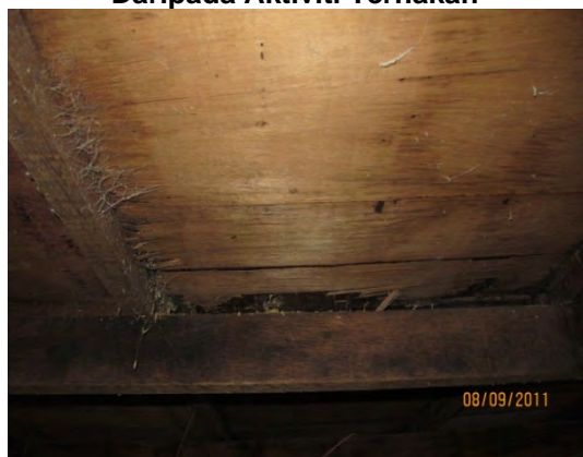
Gambar 5.1 Lantai Reban Daripada Papan Lapis Mula Mereput Kesan Kelembapan Pada Kayu Daripada Aktiviti Ternakan
