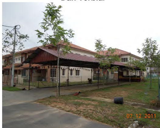
Gambar 10.8 Kafeteria Yang Tidak Digunakan Dan Terbiar
