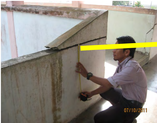
Gambar 4.2 Keretakan Berlaku Di Bahagian Dinding Laluan Berbumbung
