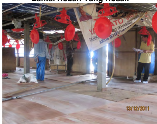
Gambar 5.6 Kontraktor Sedang Membuat Kerja Penyenggaraan Reban Dengan Mengganti Lantai Reban Yang Rosak
