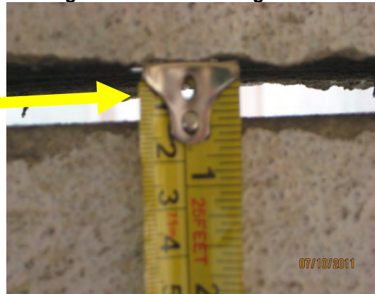
Gambar 4.2 Keretakan Berlaku Di Bahagian Dinding Laluan Berbumbung
