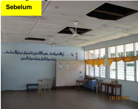
Gambar 4.10 Siling Yang Telah Rosak Dan Berlubang
