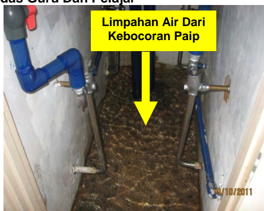
Gambar 4.19 Kebocoran Paip Di Tandas Guru Dan Pelajar
